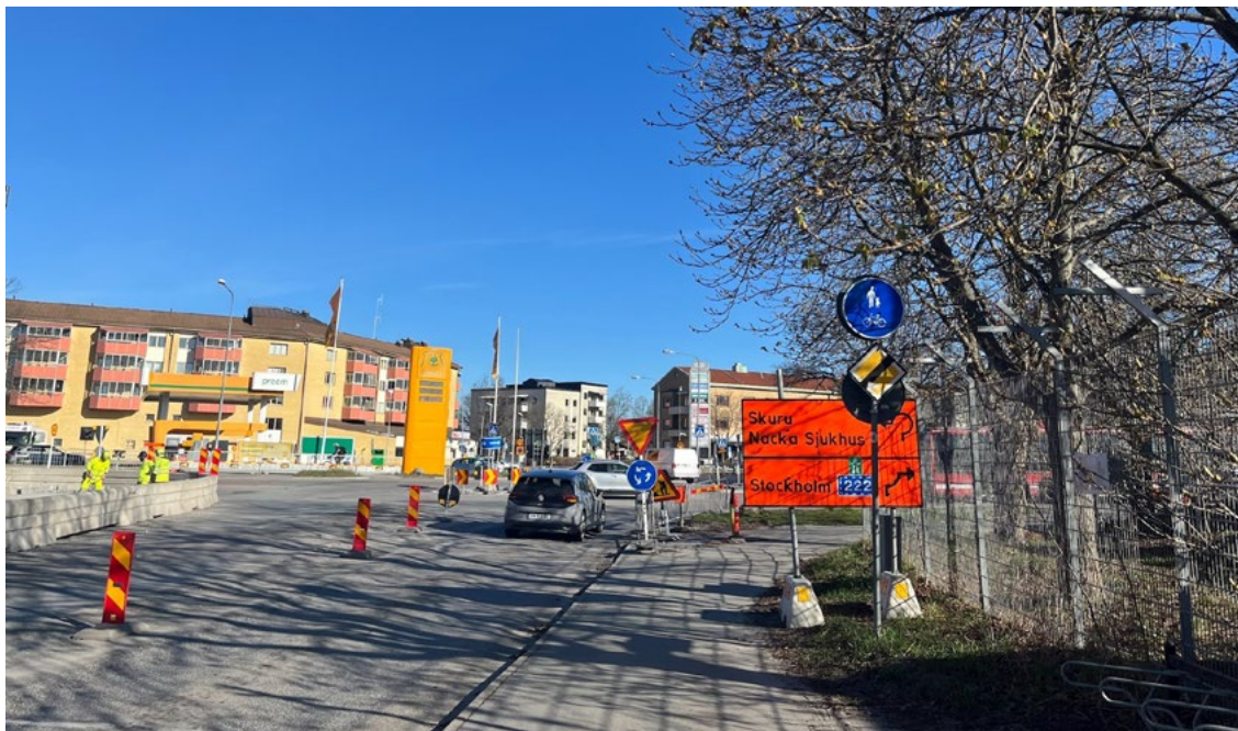
Trafikplats Björknäs. Bild: Trafikverket.
